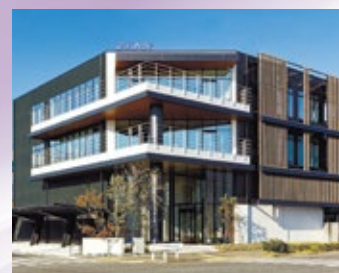
2022年に完成した新本社・工場
