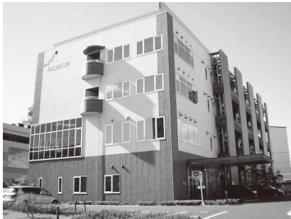
鉄骨造り4階建て インキュベーションルーム全50室 (30㎡タイプまたは60㎡タイプ)
