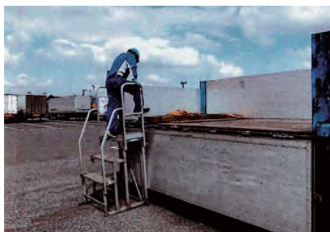
墜落・転落防止:昇降台の導入
